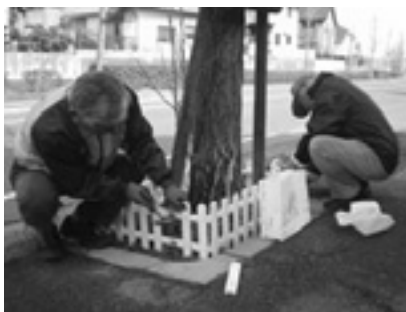
柵の修理作業
