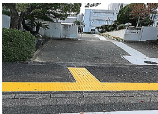
補修された点字ブロック
